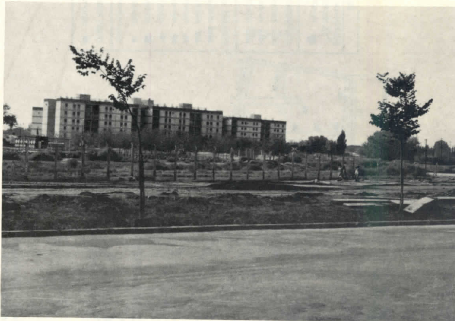
Fot. 4 — Monobloques del conjunto habitacional de calle Pellegrini.
