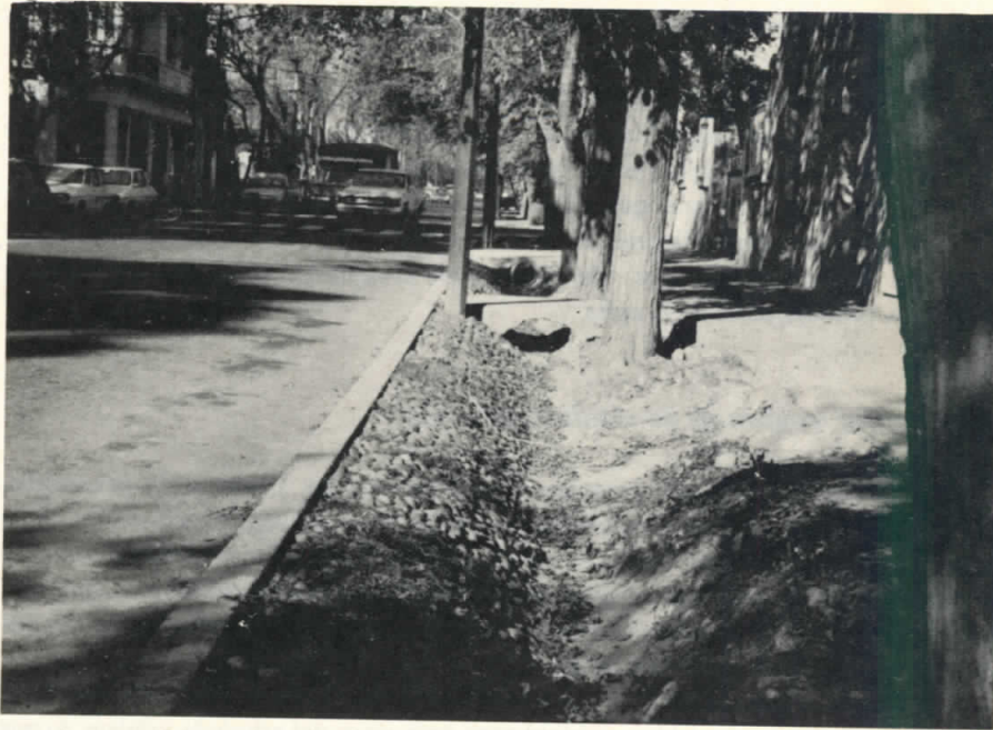
Fot. 7 — Típica acequia mendocina, recubierta de cantos rodados, en calle Perú, sistema que favorece el riego del arbolado público.
