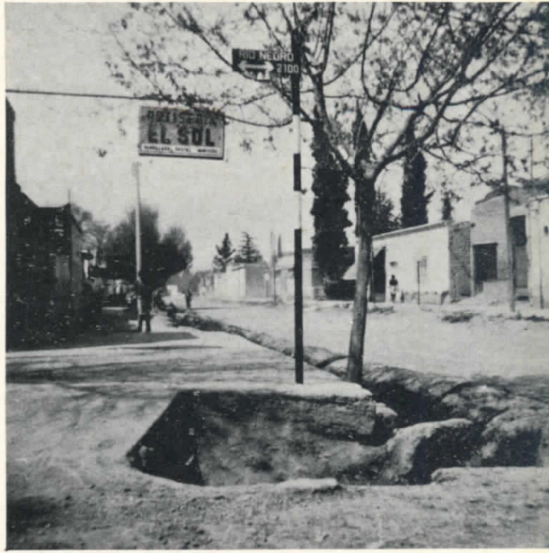
Fot. 3 — Sector en evidente estado de deterioro en Pedro Molina, Guaymallén.
